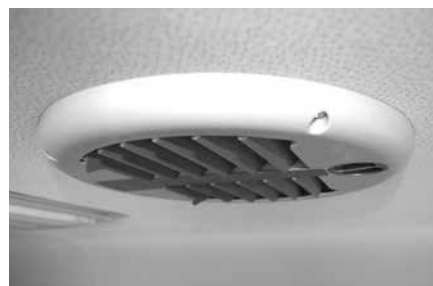
Elektrischer Be- und Entlüfter
