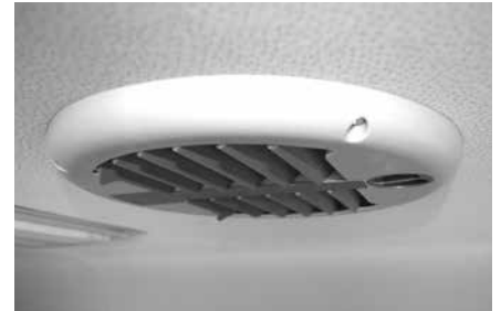
Elektrischer Be- und Entlüfter
