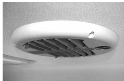
Elektrischer Be- und Entlüfter
