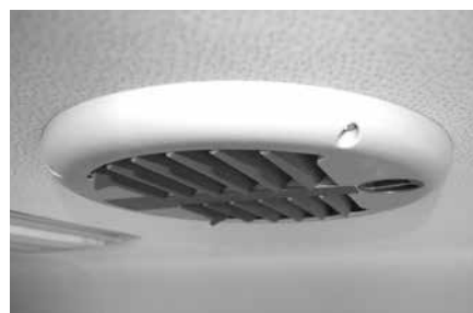
Elektrischer Be- und Entlüfter
